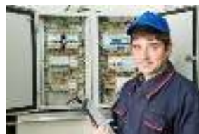
распределительные телефонные и электрощиты
